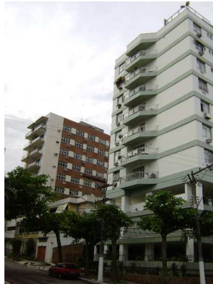
Foto19: Bairro Boa Viagem - edificações. Fonte: SUEP-UFF (2009)
