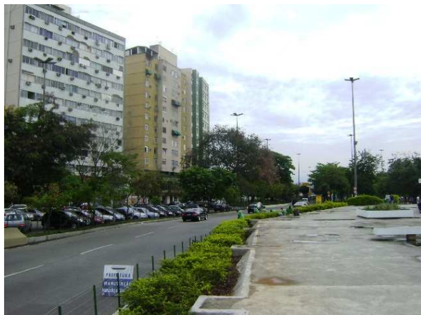
Foto 17: Av. V. do Rio Branco - fachadas e volumetrias mais altas. Fonte: SUEP-UFF (2009)
