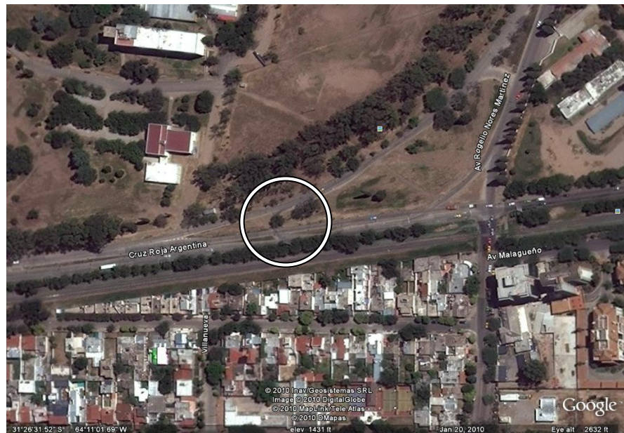
Figura 4.1. Vista de la intersección seleccionada
