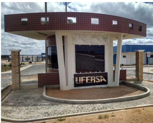
Figura 4: Entrada do Campus Fonte: Ufersa (2014)
