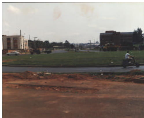
Figura 4.25 – Av. Rondon Pacheco – sentido BR 050 (1989) Fonte: SETTRAN (1989)
