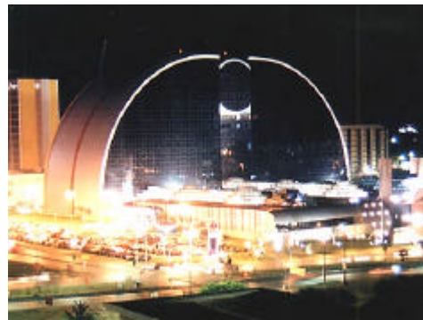
Figura 2.16 – Brasília shopping and Towers, Brasília, DF. Fonte: ABRASCE, 2004.
