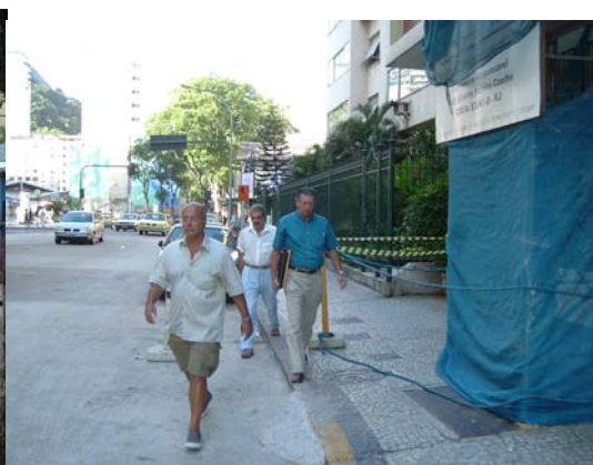
Figura 5.19 Obra em condomínio
