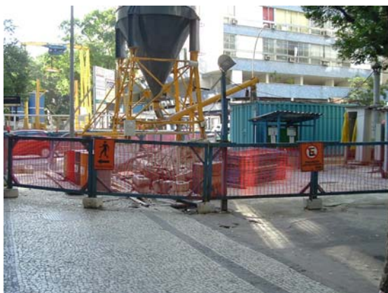
Figura 5.18 Canteiro de obras do Metrô
