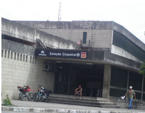
Foto 4.3 Vista Externa da Estação Coqueiral
