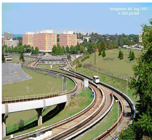
Figura 2.10 – Vista parcial do sistema
