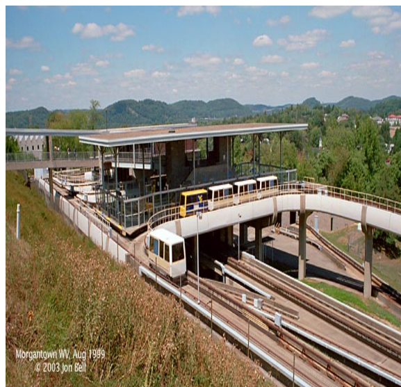
Figura 2.11 – Vista da estação
