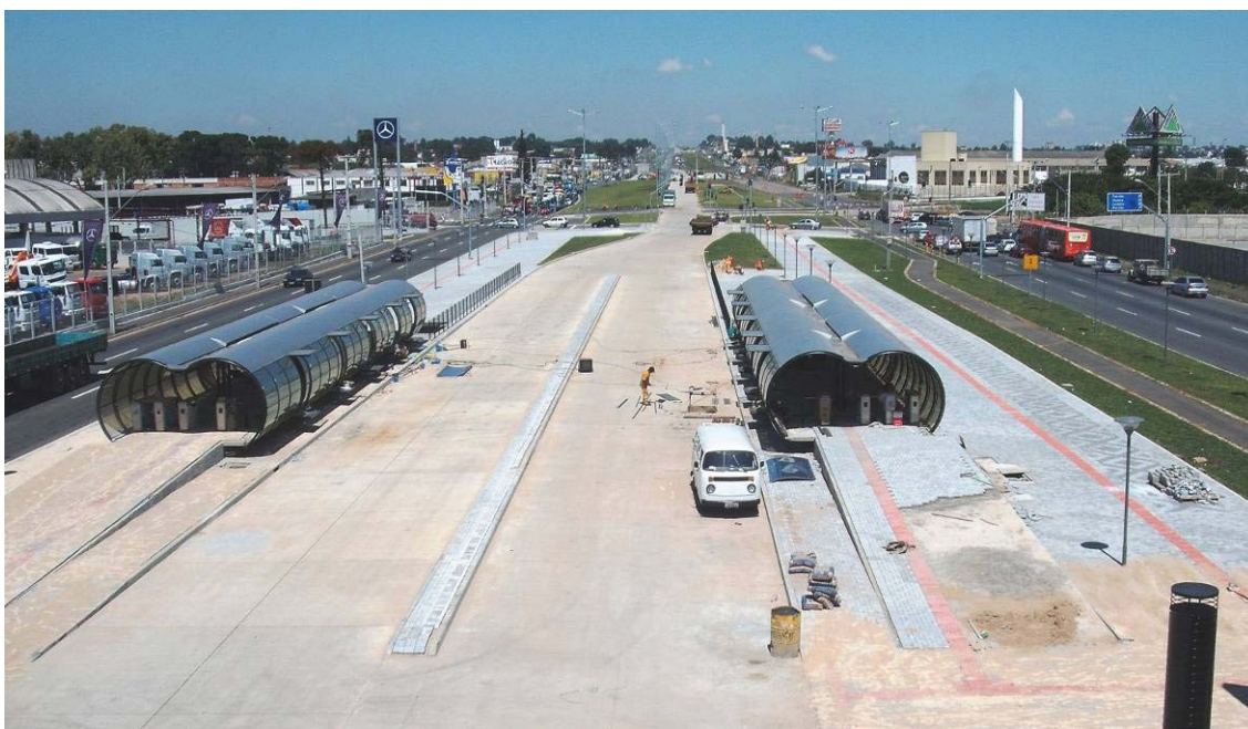
Figura 9: Obras de implantação da Linha Verde
