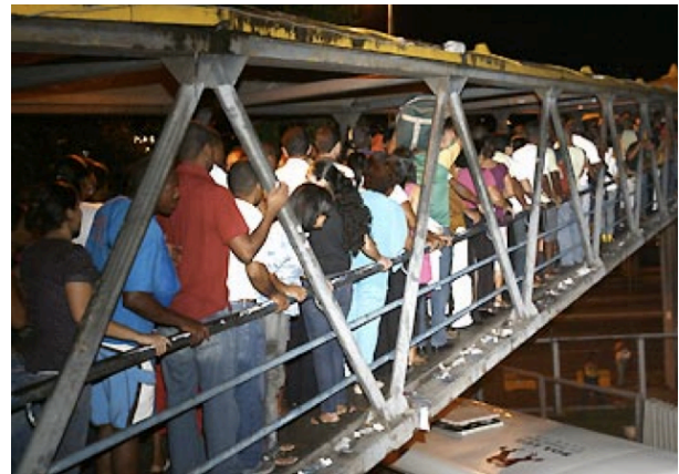
Figura 4.8 – Analogia. Passarela ligando uma estação rodoviária a um shopping existente em Salvador. Fonte: Jornal A Tarde.
