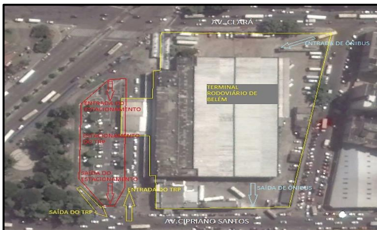
Figura 9 - Vista de cima do TRP de Belém
