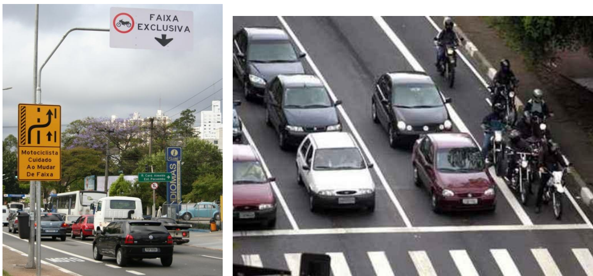
Figura 6 – Faixa segregada para motocicletas em São Paulo Fonte: Uol (2006) e Estadão (2006)
