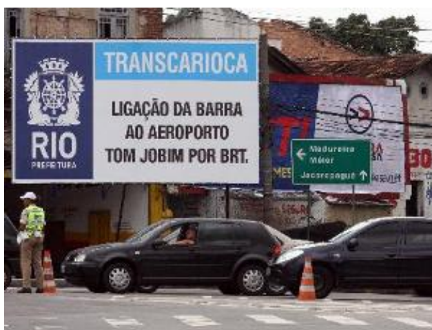
Figura 1.2: Obras do BRT Transcarioca, iniciadas em março
