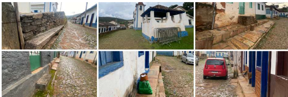
Figura 14: Destques da aplicação em São Bartolomeu.
