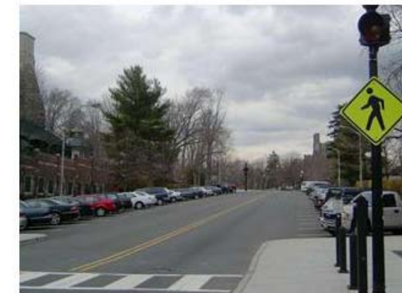
Fig.A.9 - Sinalização vertical e horizontal
