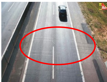
Figura III.2 - Sensores na pista Fonte: Empresa Engebrás
