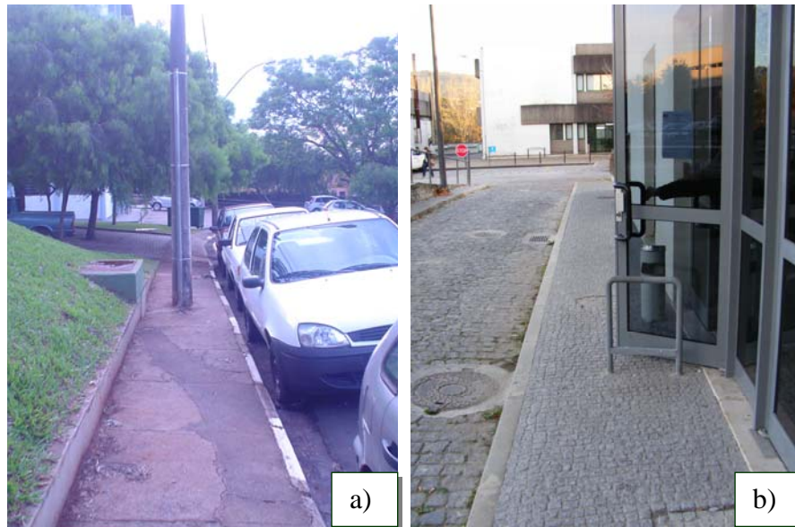
Figura 5.3: Exemplo de obstáculos que reduzem a largura efetiva das calçadas no campus de São Carlos (a) e no campus de Gualtar (b)
