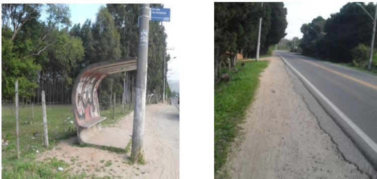
Figura 35 – Deficientes condições oferecidas aos modos sustentáveis na Rodovia João Gualberto Soares
