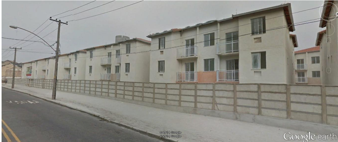
Figura 44 - Grupamento residencial com testada para duas ruas, o acesso é realizado por apenas uma delas. Resultado: um muro de mais de 100m sem aberturas em bairro de zona de uso misto. Fonte: Google Street View
