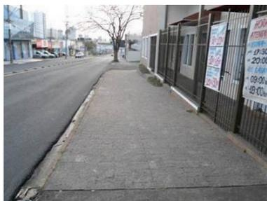
**Figura 97 - Largura efetiva da calçada inadequada devido à obstrução permanente de vegetação**
