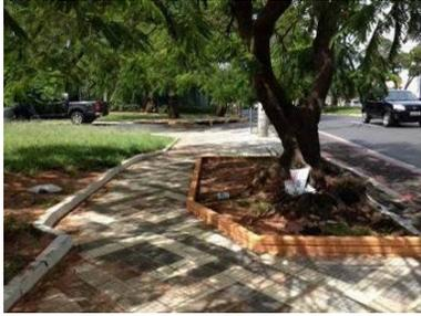
Figura 102 - Degrau, estado de conservação do piso e obstrução permanente
