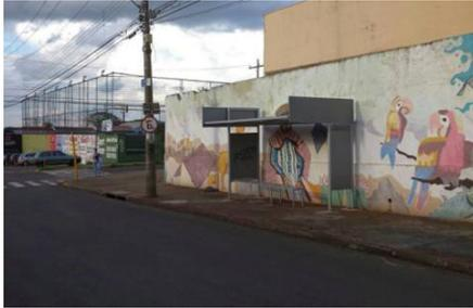
Figura 89 - Ausência de rebaixamento de guia e sinalização vertical de travessia
