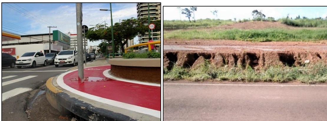
Figuras 2.8 e 2.9: Exemplos de ciclovias não sustentáveis respectivamente em Manaus (poste) e em Brasília (talude erodido) (GLOBO, 2015 e ASSOCIAÇÃO PARK WAY RESIDENCIAL, 2015)
