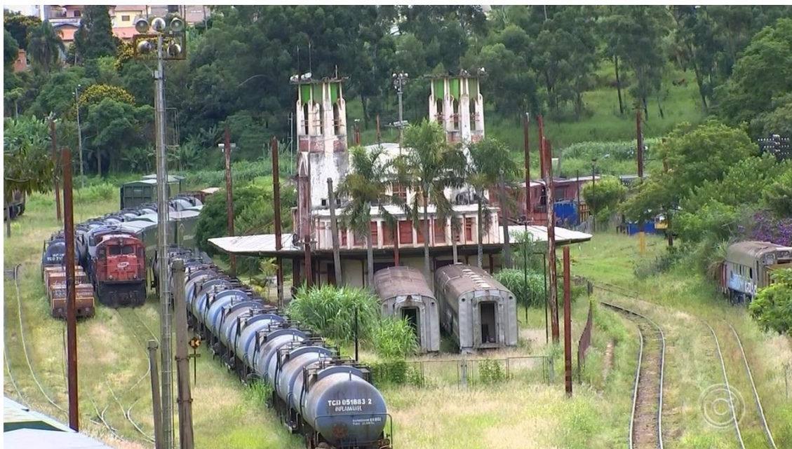
Figura 13. Estação Mairinque. Edifício tombado pelo IPHAN e CONDEPHAAT.
