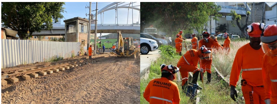
Figura 73. Manutenção na Via Permanente do Trem Rio Minas (2022).
