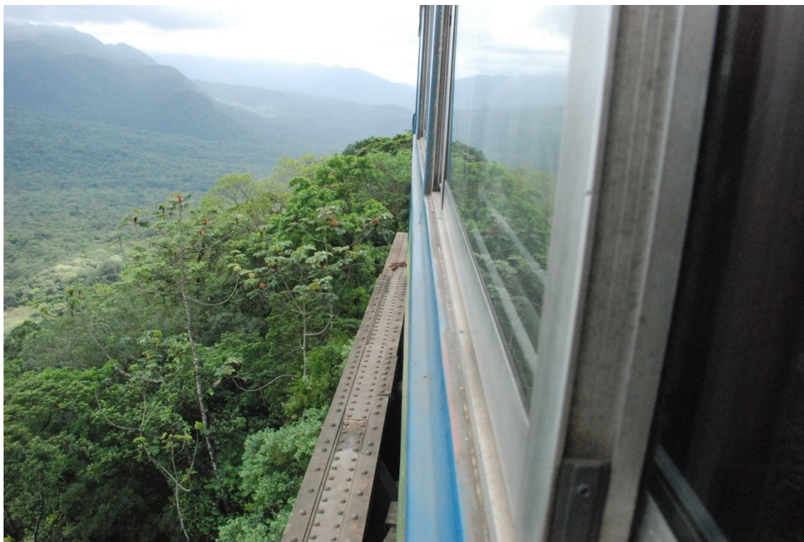
Figura 40. Visão no Viaduto do Carvalho
