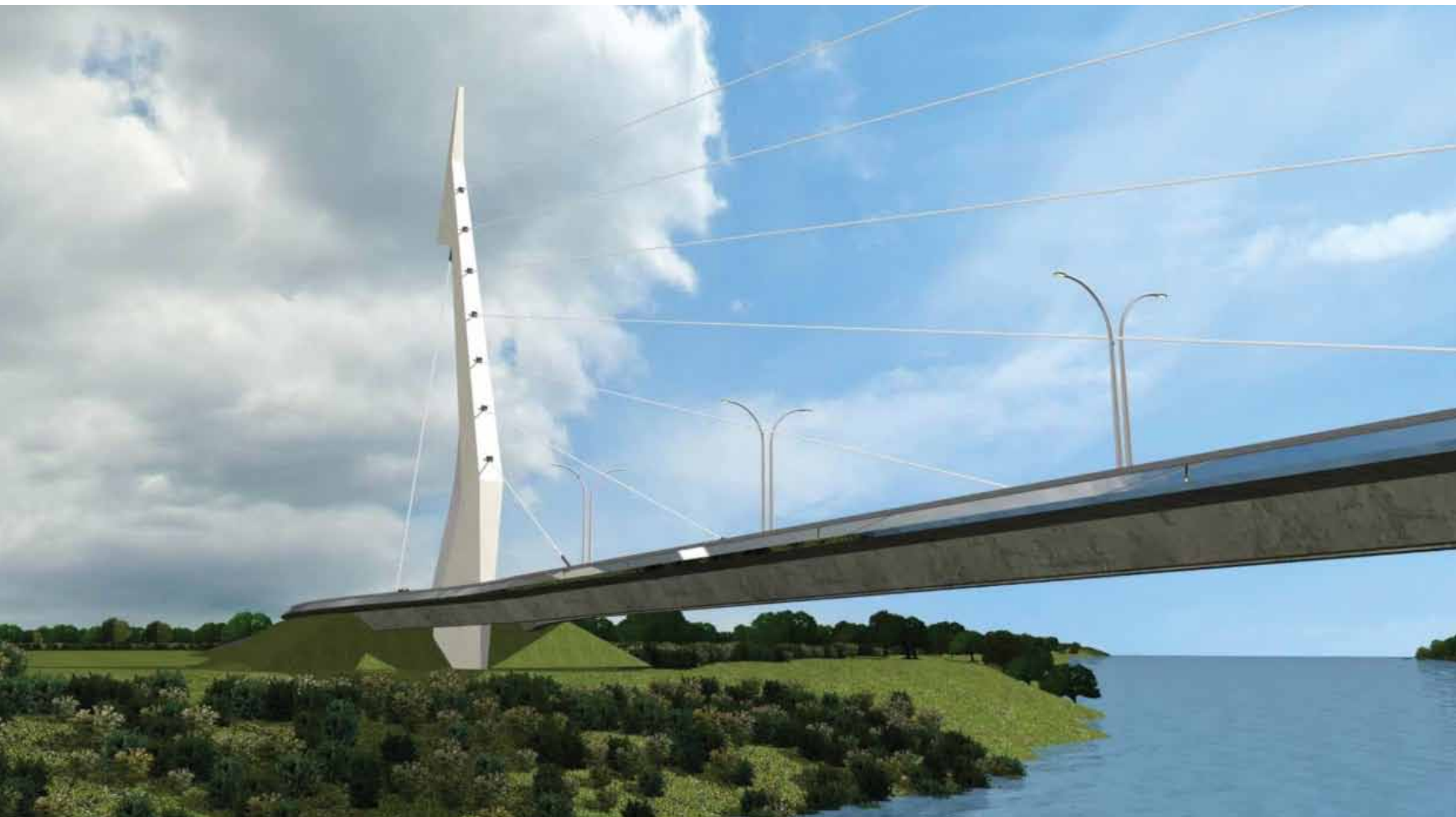
Fonte: Vídeo - Ponte do Canal. Arquiteto Alexandre Chan.
